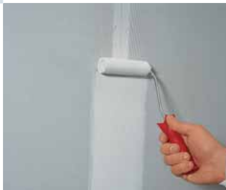
Afbeelding 3.14: Aanbrengen van de FERMACELL Powerpanel HD Wapeningslijm
