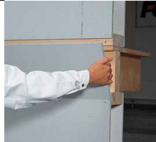
Afbeelding 4.11: Montage van de plaatstroken
