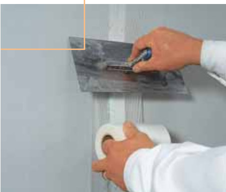
Afbeelding 3.13: Aanbrengen van de FERMACELL Powerpanel HD Wapeningsband
