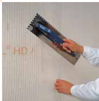
Afbeelding 3.20: Overlappen van het FERMACELL Powerpanel HD Wapeningsweefsel met ca. 10 cm overlap
