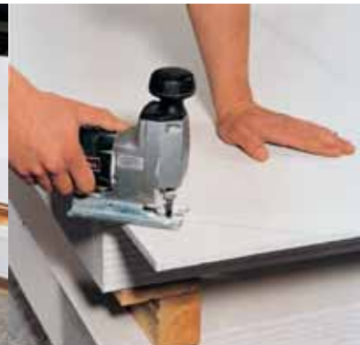
Afbeelding 3.4: Gebruik van de decoupeerzaag voor rondingen en aanpassingen
