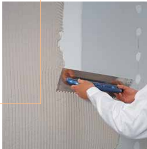
Afbeelding 3.16: Aanbrengen van de FERMACELL Powerpanel HD Basismortel
