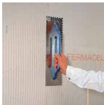
Afbeelding 3.19: Indrukken van de FERMACELL Powerpanel HD Wapeningsweefsel in het basismortel bed
