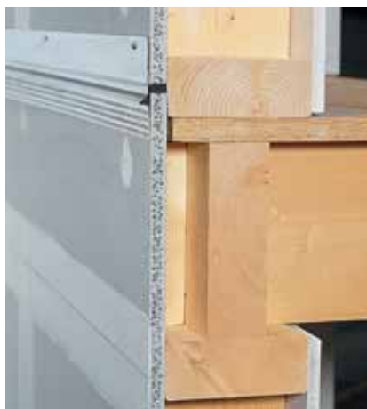
Afbeelding 4.15: Gemonteerde plaatstrook met FERMACELL Powerpanel HD Vloeraansluitingsprofiel
