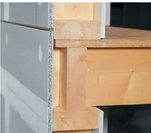
Afbeelding 4.12: Plaatstrook afgewerkt aan de onderzijde met de voegtechniek
