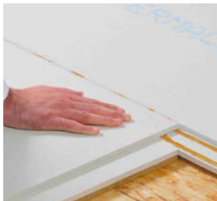
Verlijmen van de vloerelementen onderling met volledig met lijm gevulde liplas
