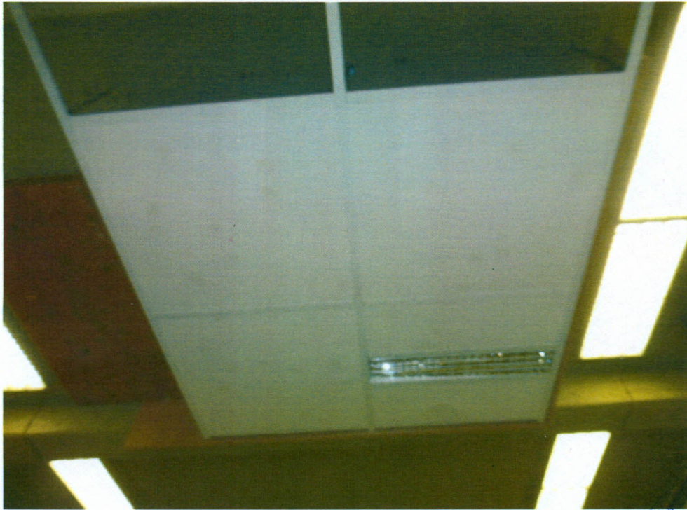
Bild 1 Gesamtansicht: Deckenunterseite mit Rasterleuchte „Olympia Plus“
