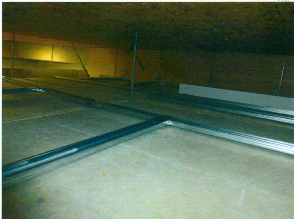
Bild 2 Gesamtansicht: Deckenunterkonstruktion „Olympia Plus“
