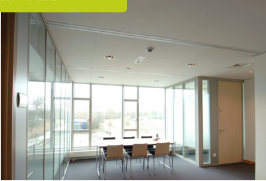
Omega semi-verdekt bandrastersysteem met verdekt gemonteerde Quick-Lock Z-dwarsprofielen.
